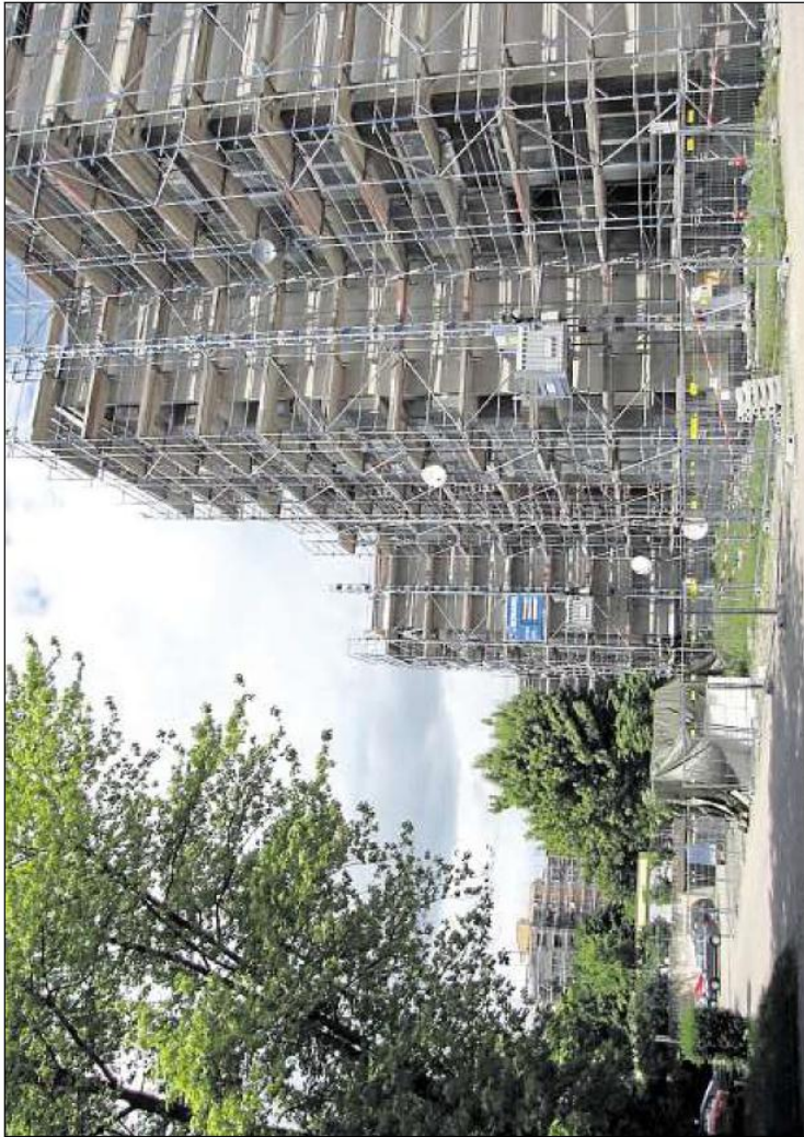
Die Maßnahmen in der Bottroper Straße schlagen mit 13,6 Millionen Euro zu Buche. Mieter wehren sich gegen eine Mieterhöhung nach Sanierungsende um bis zu 60 Prozent. Foto: Rehberger
