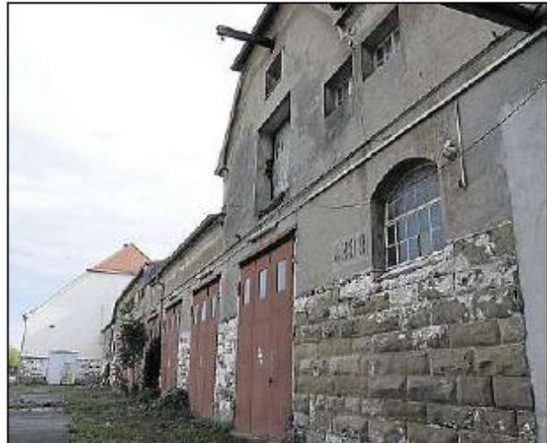
In dem Gebäude 4309 waren einstmalig Stallungen untergebracht. Hier werden sich künftig die Umkleideräume befinden.
