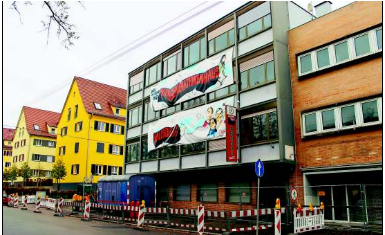
Seit einigen Tagen ist die Baustelle endlich eingerichtet. Nun kann der Abriss beginnen.
