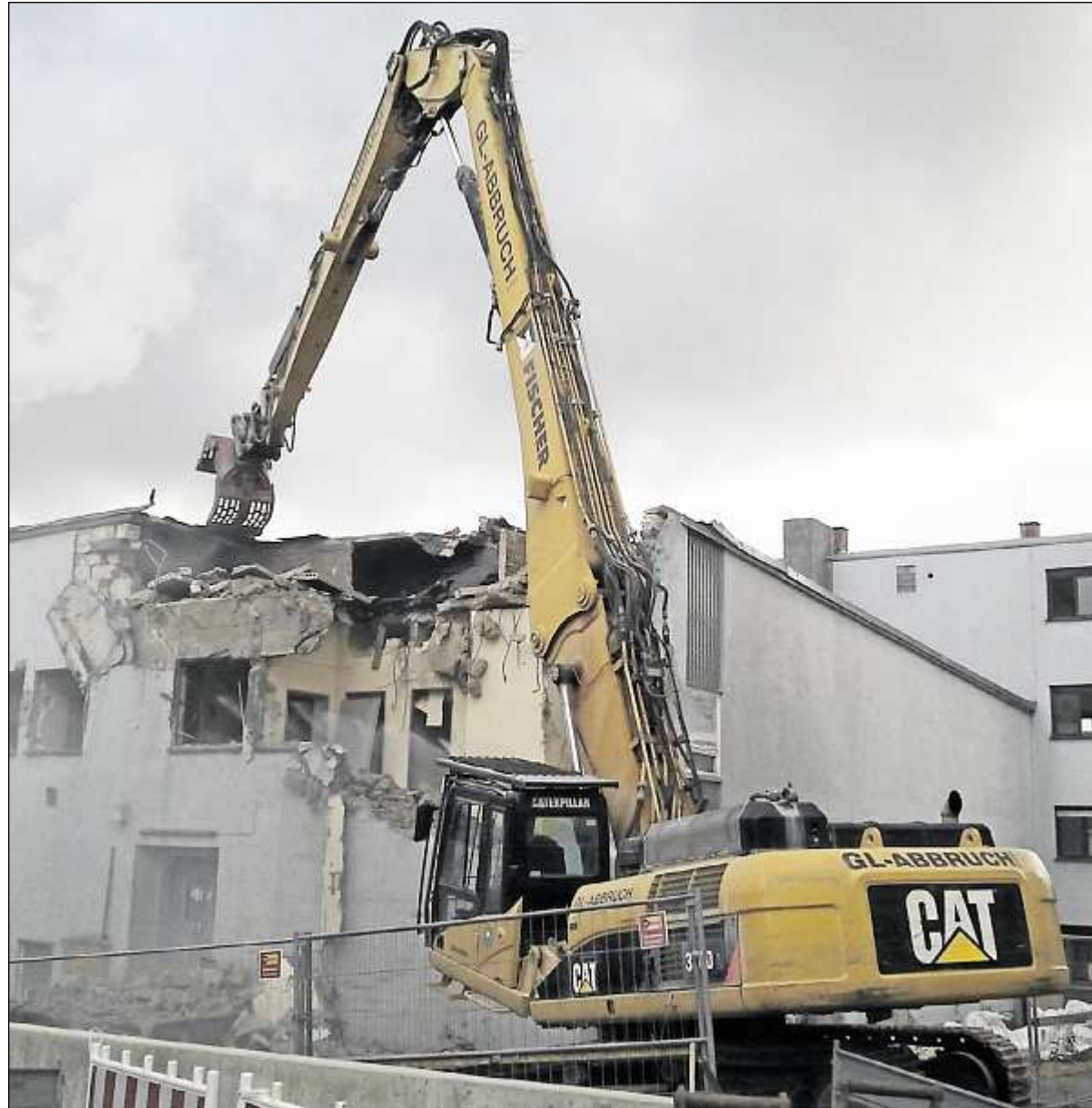
Die Abbrucharbeiten für das Gebäude am Römerkastell 69 haben begonnen.
