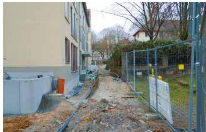
Verlauf des Weges Blickrichtung Norden
