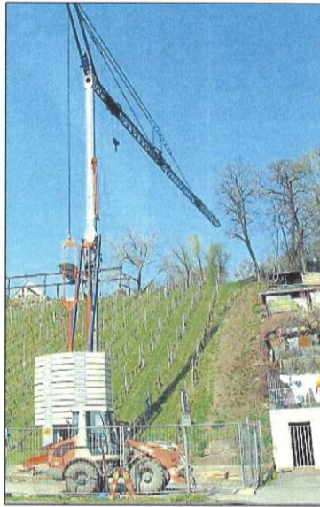
Hier entsteht die Treppe zum Travertinpark von der Haldenstraße aus.
