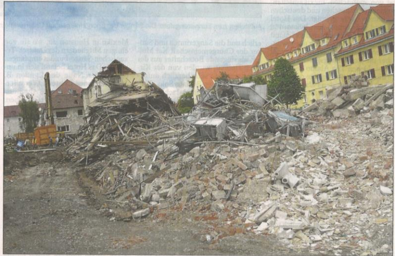
Der Abbruch der zum Teil 80 Jahre alten Gebäude entlang der Straße Im Hallschlag ist fast abgeschlossen. Für knapp 5,3 Millionen Euro entstehen hier 34 neue Wohneinheiten. Foto: Nagel
